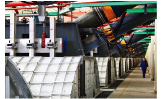
山东魏桥电解铝项目
